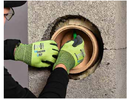
Ühendustoru abil märgitakse vajalik ava mõõt šamott-torule.
