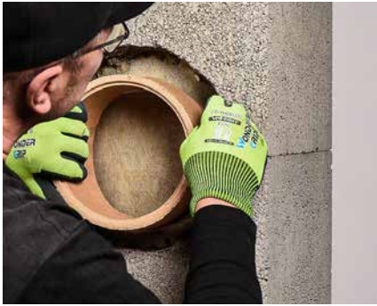
Ühendustoru abil kantakse mõõt villale.
