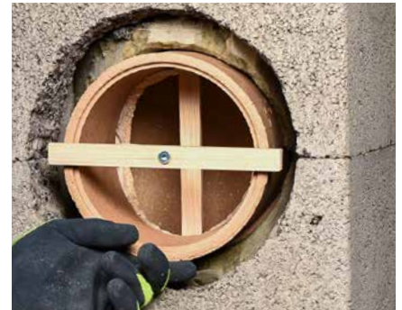
Lisaühendus fikseeritakse šamott-toru külge, kasutades selleks kohandatud puidust fiksaatorit.
