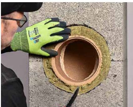
Lisaühendustoru ümber paigaldatakse vill ja viimistletakse ühendus.
